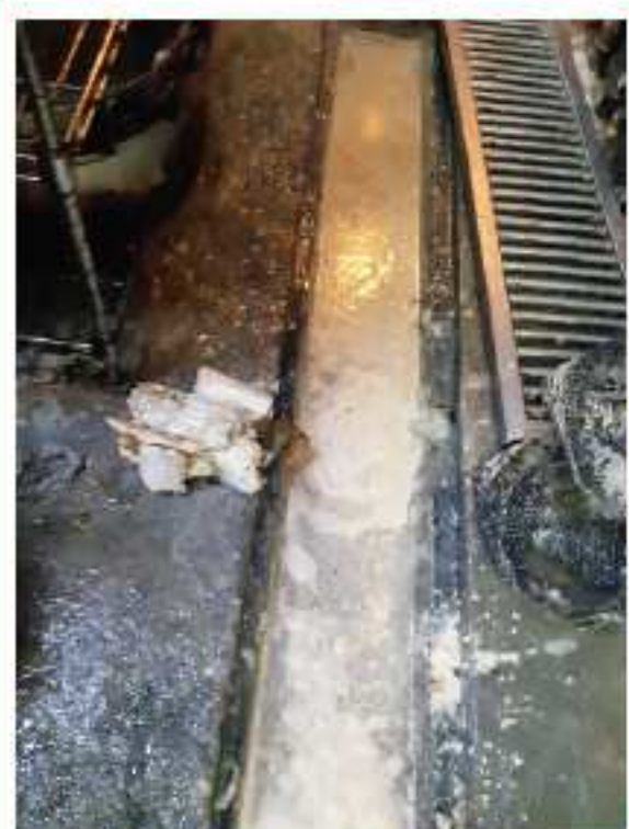
かき出した排水溝内部の汚れ
