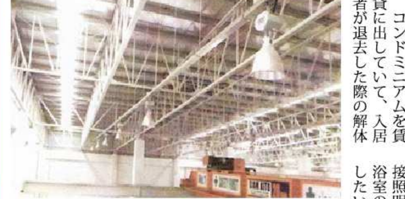
工場の電気工事
