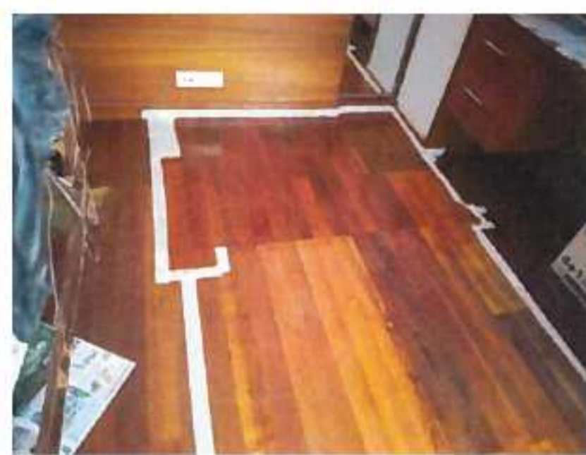
フローリングの張り替え
