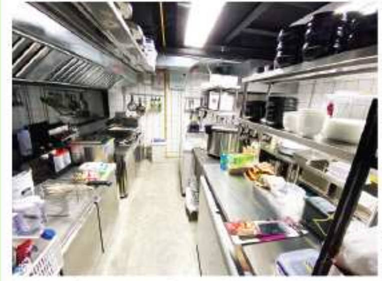
排気ダクト、ガス設備、製氷機配置(製氷排水敷設)など、シェフのご要望通り設計・施工致します。
