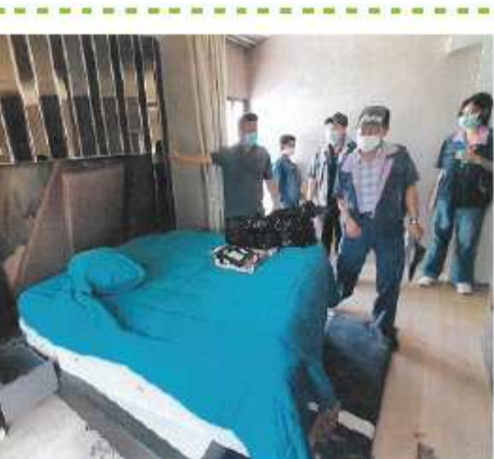
コンドミニウムの改装工事
