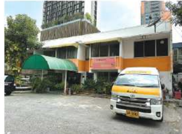
オレンジハウスの外観
