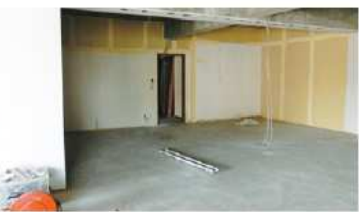
内装関係の工事
