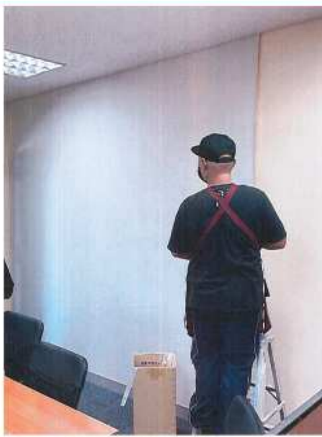
壁紙の張り替え工事
