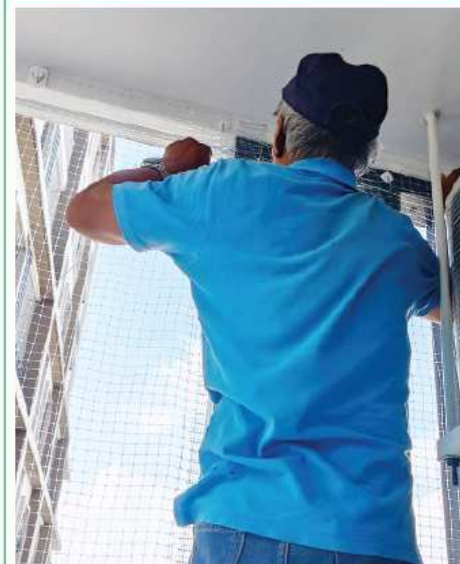
ハトネット張り工事
