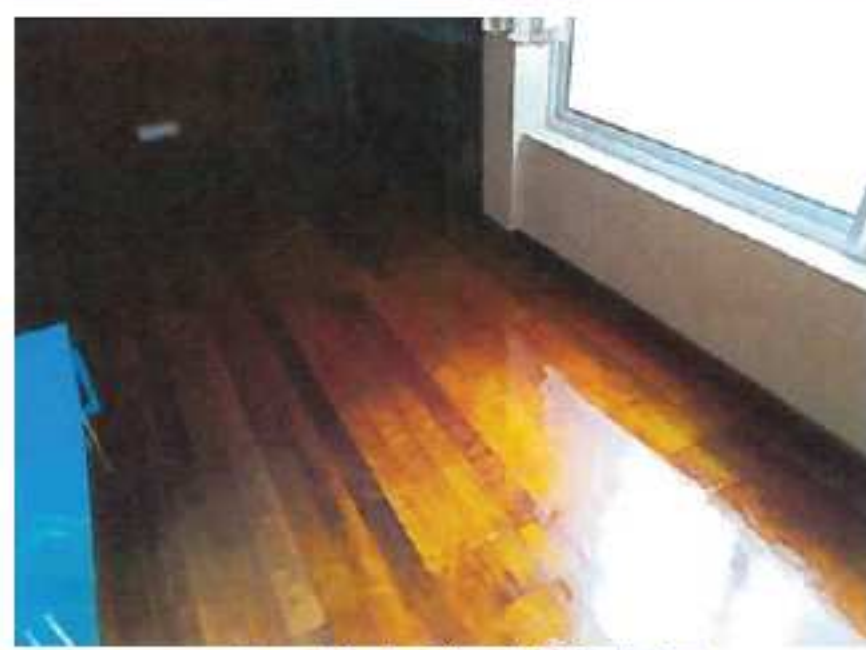
ニスで仕上げて補修完了
