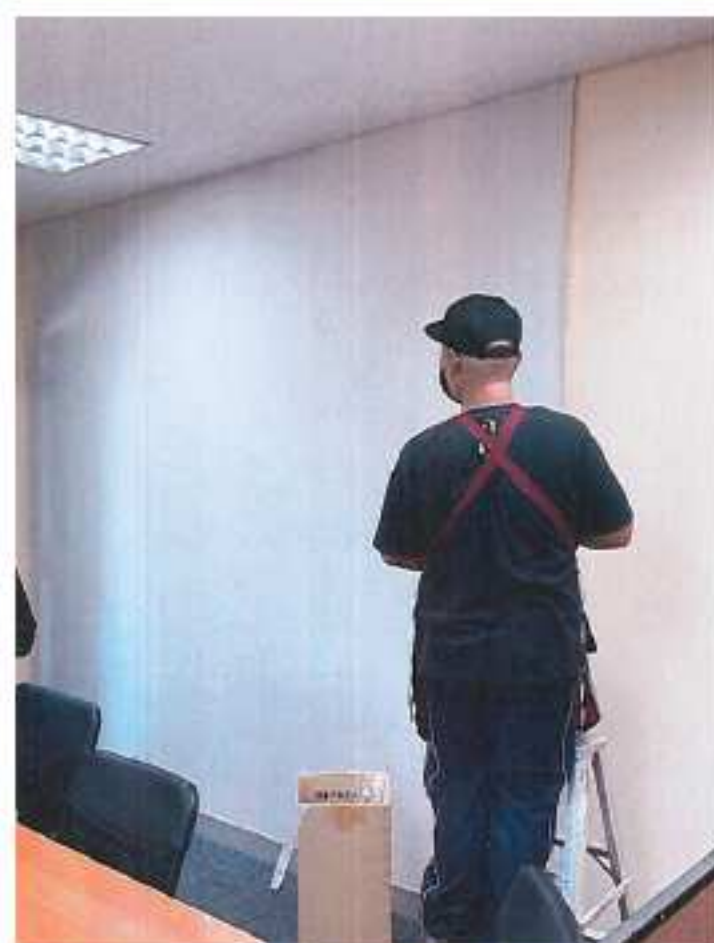
壁紙の張り替え工事
