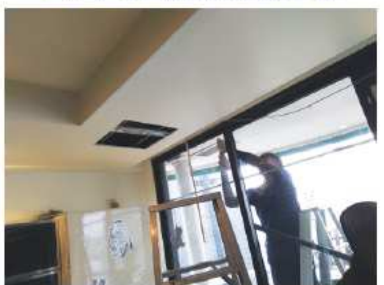
配管や電気配線の工事もあります
