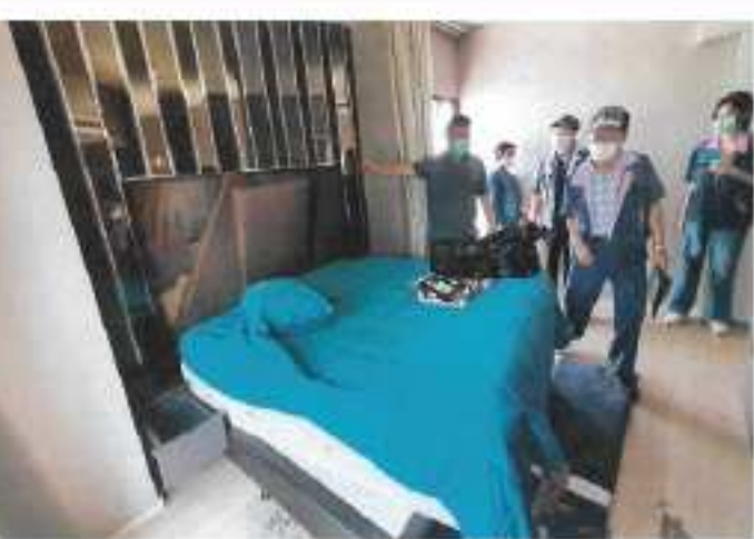
コンドミニアムの改装工事
