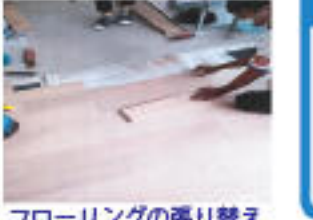
フローリングの張り替え
