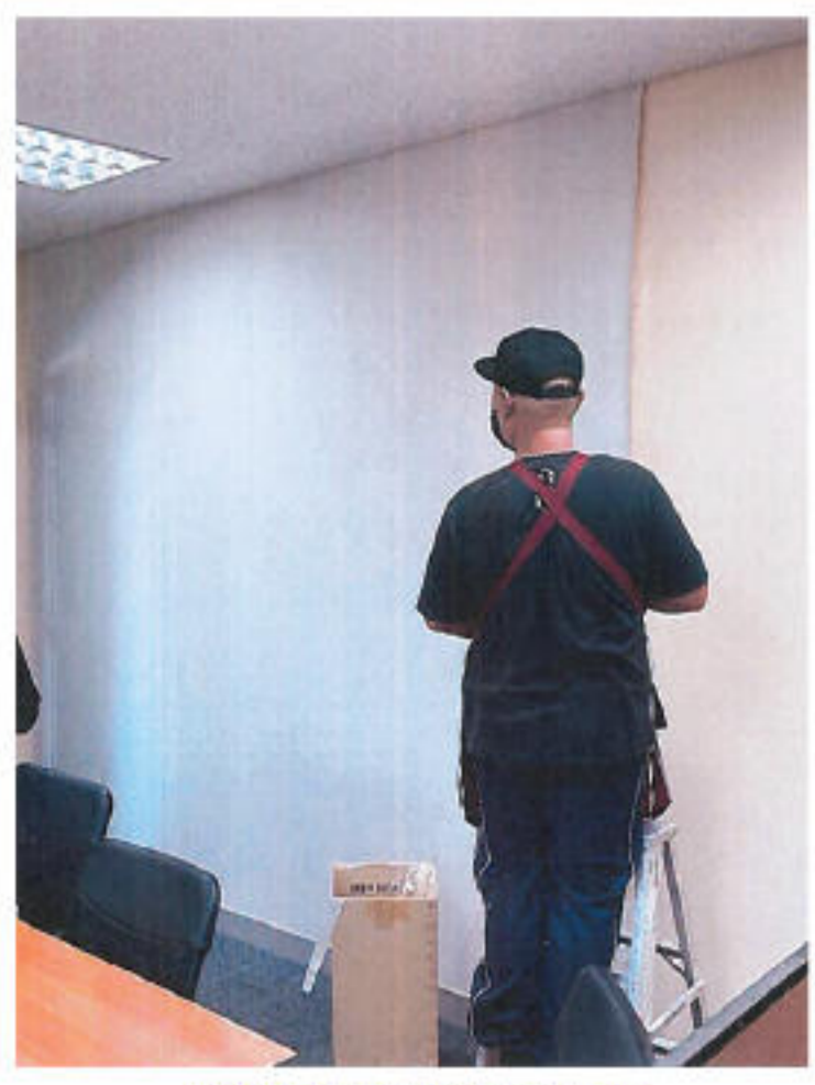
壁紙の張り替え工事
