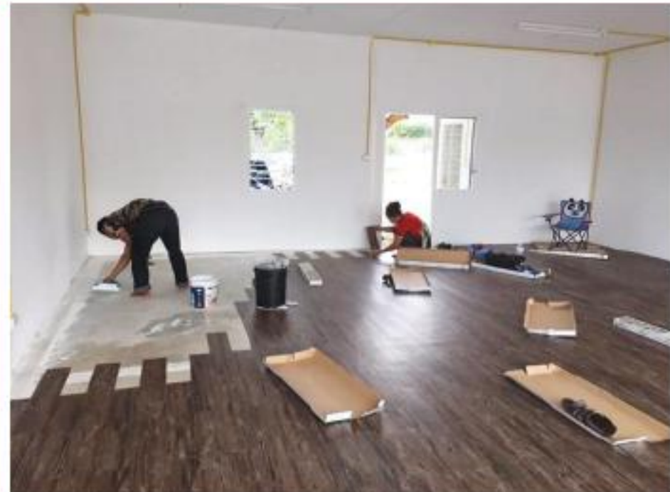
床の張り替えや壁の塗り替え
