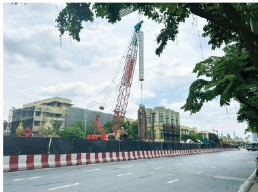
道路向かいの建物が図書館。すぐ裏手がカオサン通り
