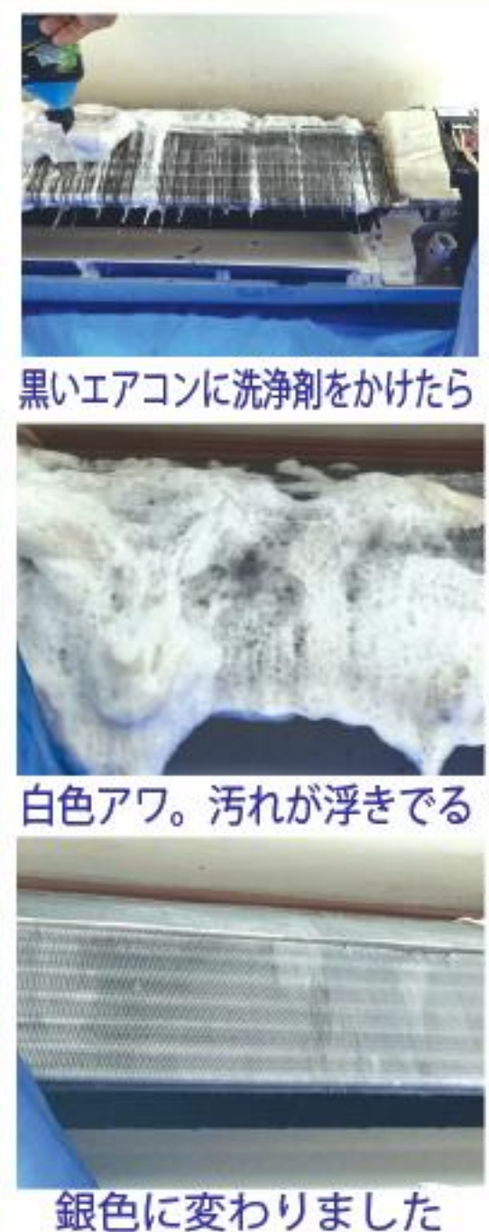
黒いエアコンに洗剤をかけた後
