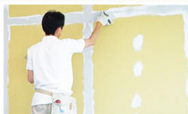
壁のメンテナンスも承ります
